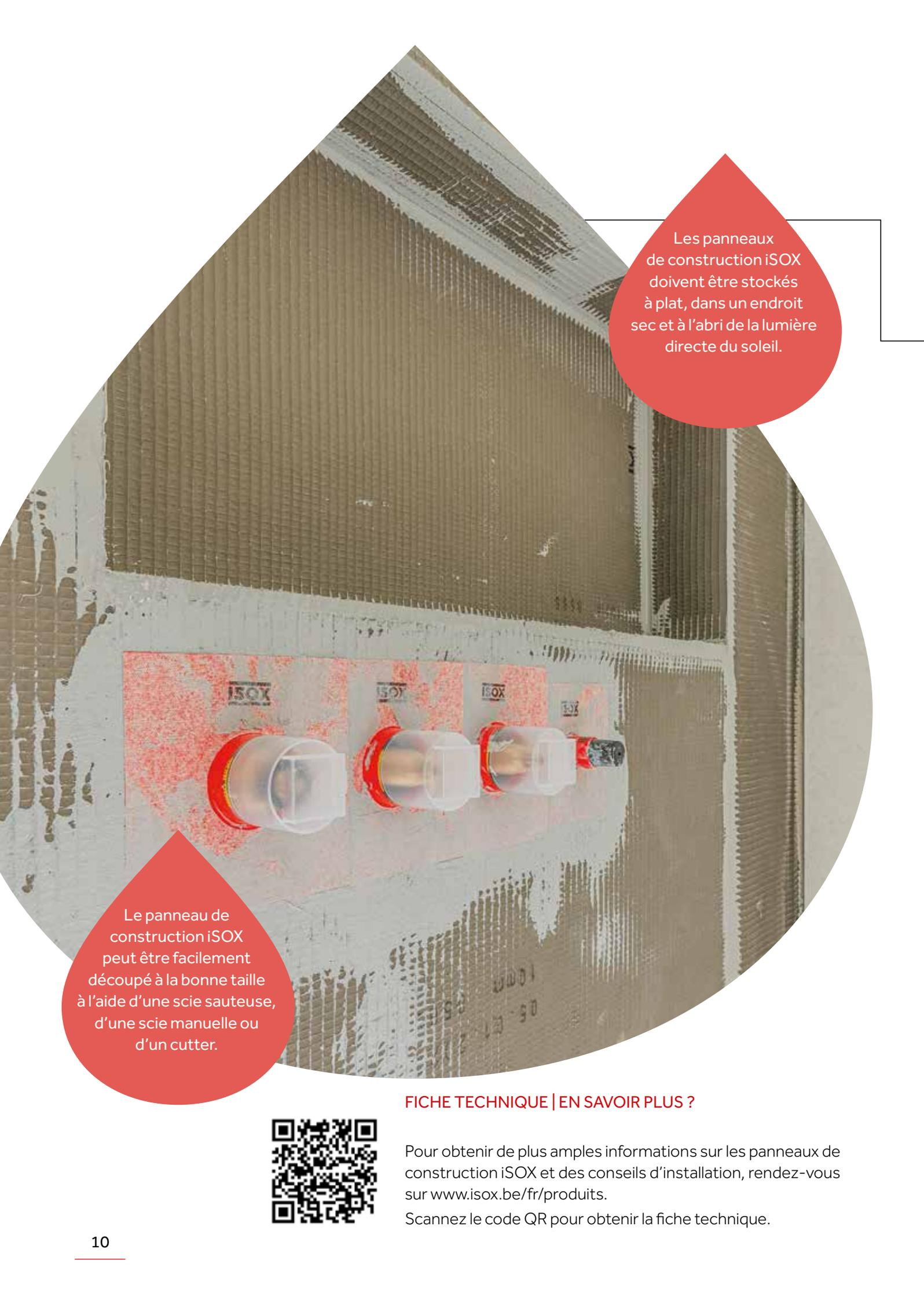
Les panneaux de construction iSOX doivent être stockés à plat, dans un endroit sec et à l'abri de la lumière directe du soleil.
