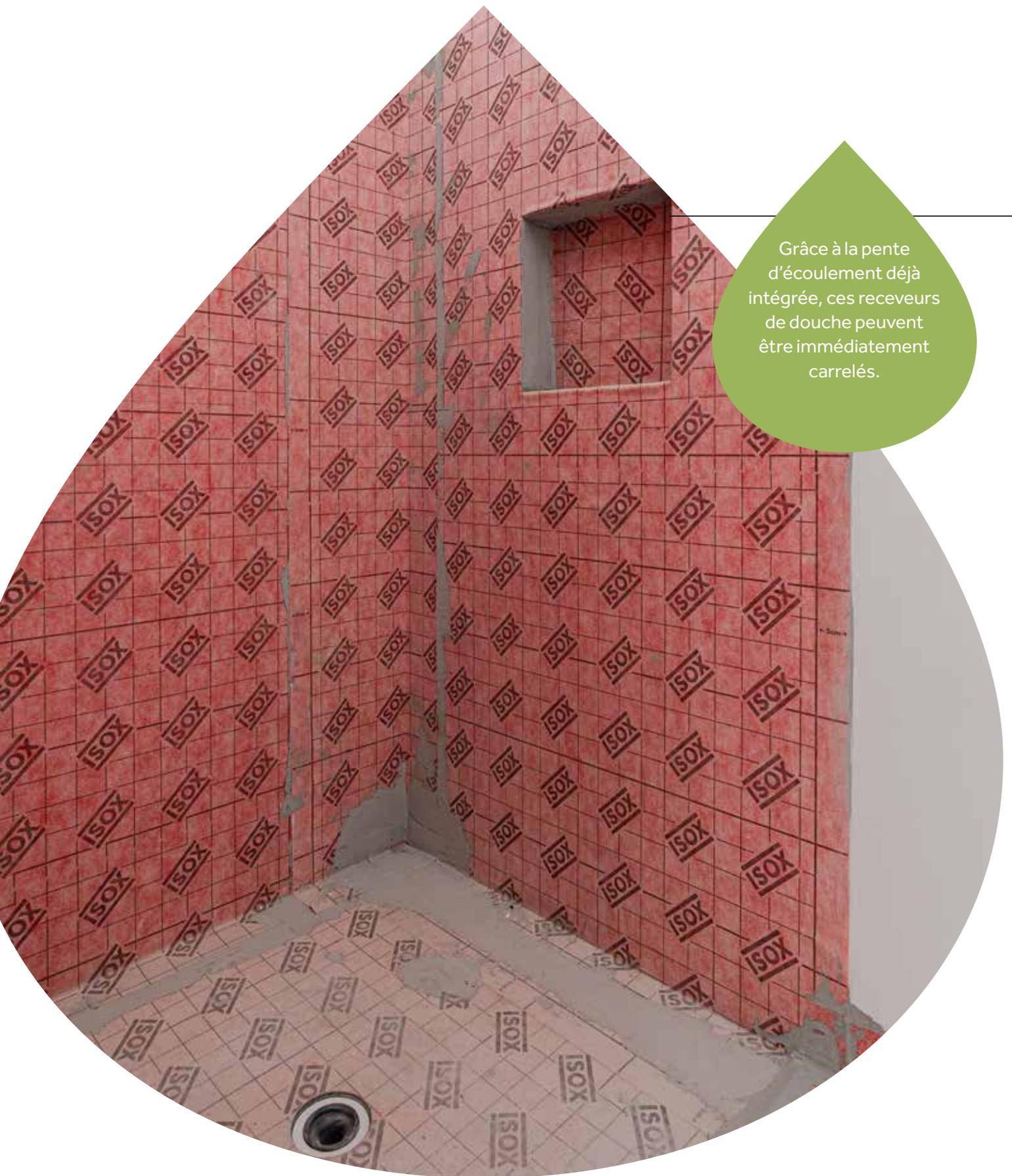
Grâce à la pente d'écoulement déjà intégrée, ces receveurs de douche peuvent être immédiatement carrelés.
